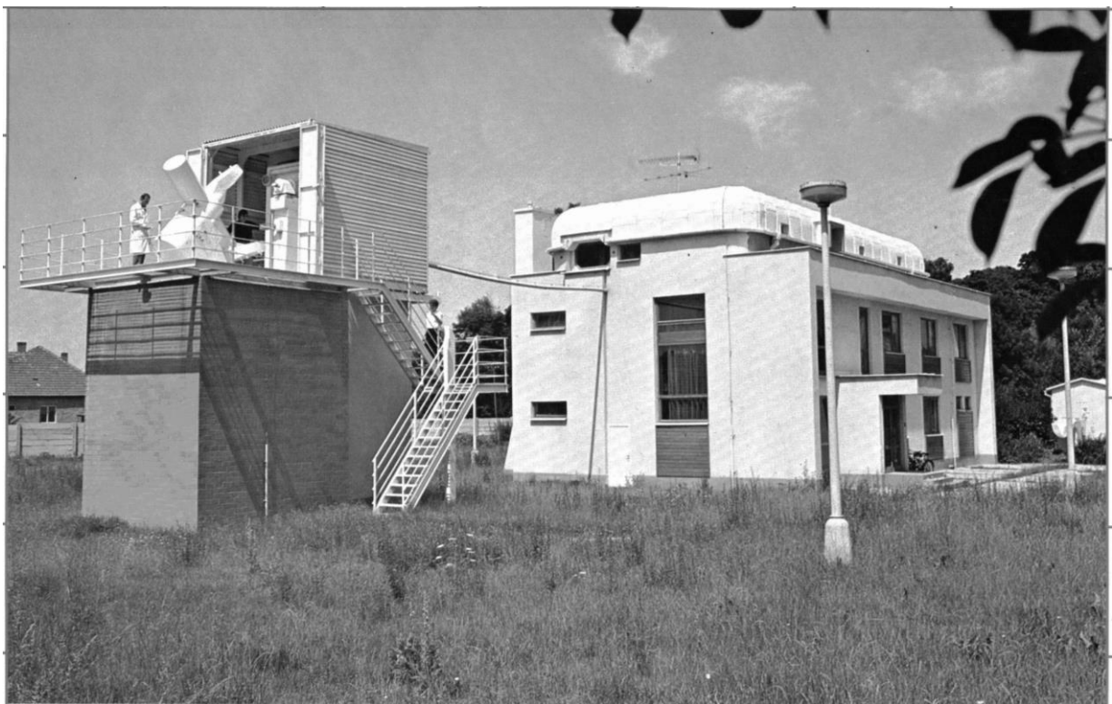
Obr. 1 Otvorená veža Jenschovej heliostatu s pozorovateľmi, od nej napravo budova HSĎS s otvoreným vstupom pre slnečné lúče a vzadu úplne vpravo pavilón historického spektroheliostatu
